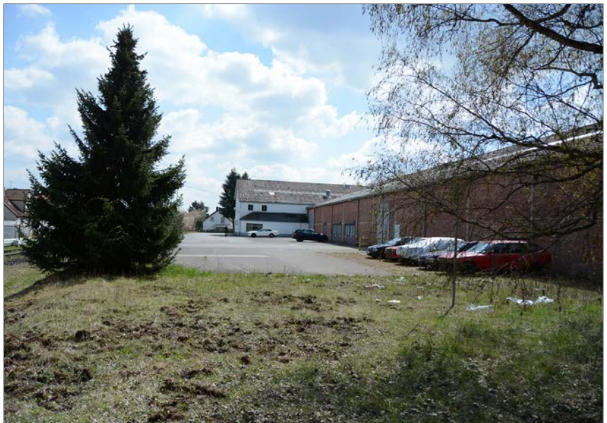
Blick von Norden in das Plangebiet mit den Bestandsgebäuden im Hintergrund
