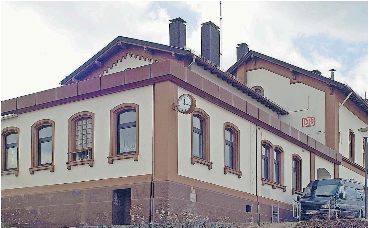
Hoch thront der Bexbacher Bahnhof über der Innenstadt. Er wurde um 1848 errichtet. Mit 160 Jahren ist das Empfangsgebäude das älteste noch erhaltene im Saarland. Außerdem ist der Bahnhof Heimat des Chores Gleis 1. Fotos: Wolf/SOL
